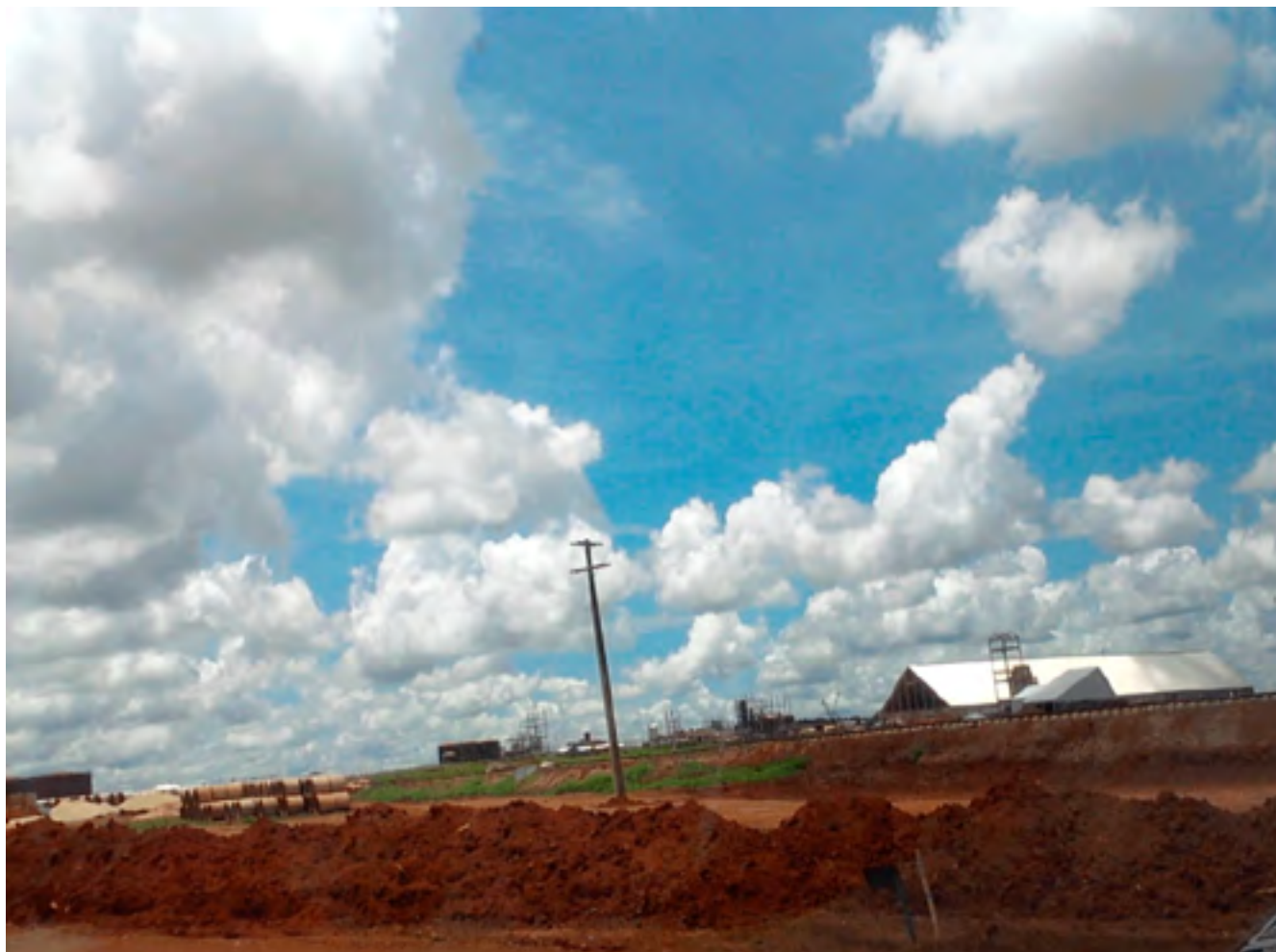
Figura 03 – Futuro Terminal Ferroviário de Rondonópolis em fase avançada de Construção
